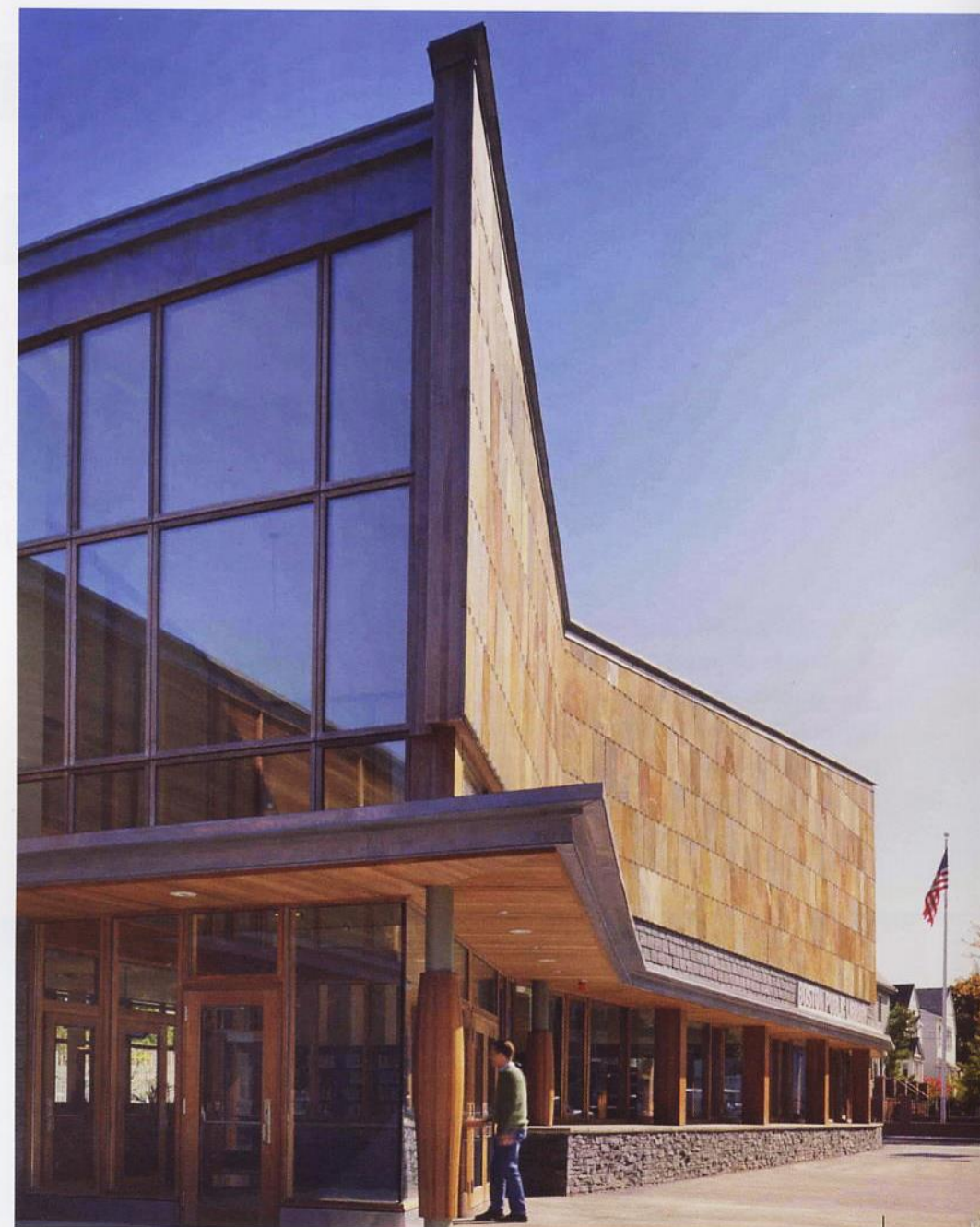
Il rivestimento della Biblioteca pubblica di Boston, progetto dello studio Machado e Silvetti Associates, è realizzato in phyllite Otta, nella qualità Rust che deve l'intensa colorazione alla presenza di ossidi minerali nella composizione.
