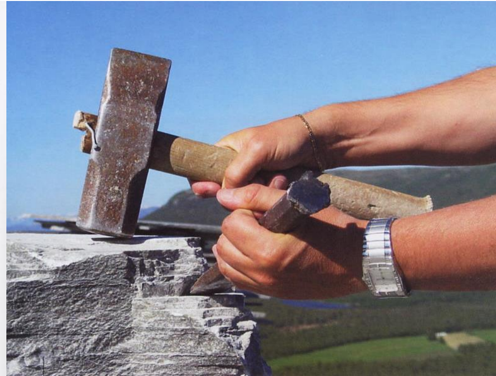
La tipica composizione a strati delle quarziti norvegesi permette di fendere le lastre secondo il verso naturale di separazione.
